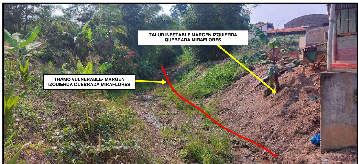
FIGURA N°01: TRAMO CRÍTICO EN LA QUEBRADA MIRAFLORES, EN EL SECTOR TERESA, DISTRITO DE UNIÓN ASHÁNINKA, PROVINCIA DE LA CONVENCIÓN - CUSCO. TALUD INESTABLE MARGEN IZQUIERDA DE LA QUEBRADA MIRAFLORES.
