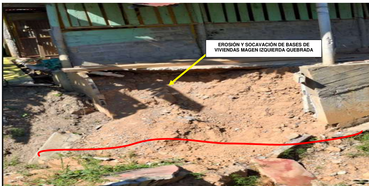
FIGURA N°02: VISTA DE EROSIÓN DE TALUD EN LA MARGEN IZQUIERDA DE LA QUEBRADA MIRAFLORES. VIVIENDA EN PELIGRO DE COLAPSO.
